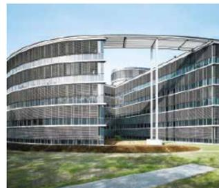
Системы управления Schüco обеспечивают автоматизированное управление солнцезащитой в соответствии с предъявляемыми требованиями. Управление системами солнцезащиты может осуществляться как вручную, так и централизованно. Встроенные датчики центральной метеостанции EIB одновременно используются в метеорологических целях, а также системой солнцезащиты.
